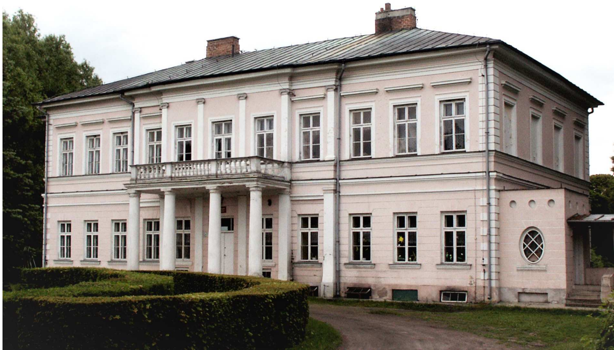
Elewacja frontowa, źródło własne
