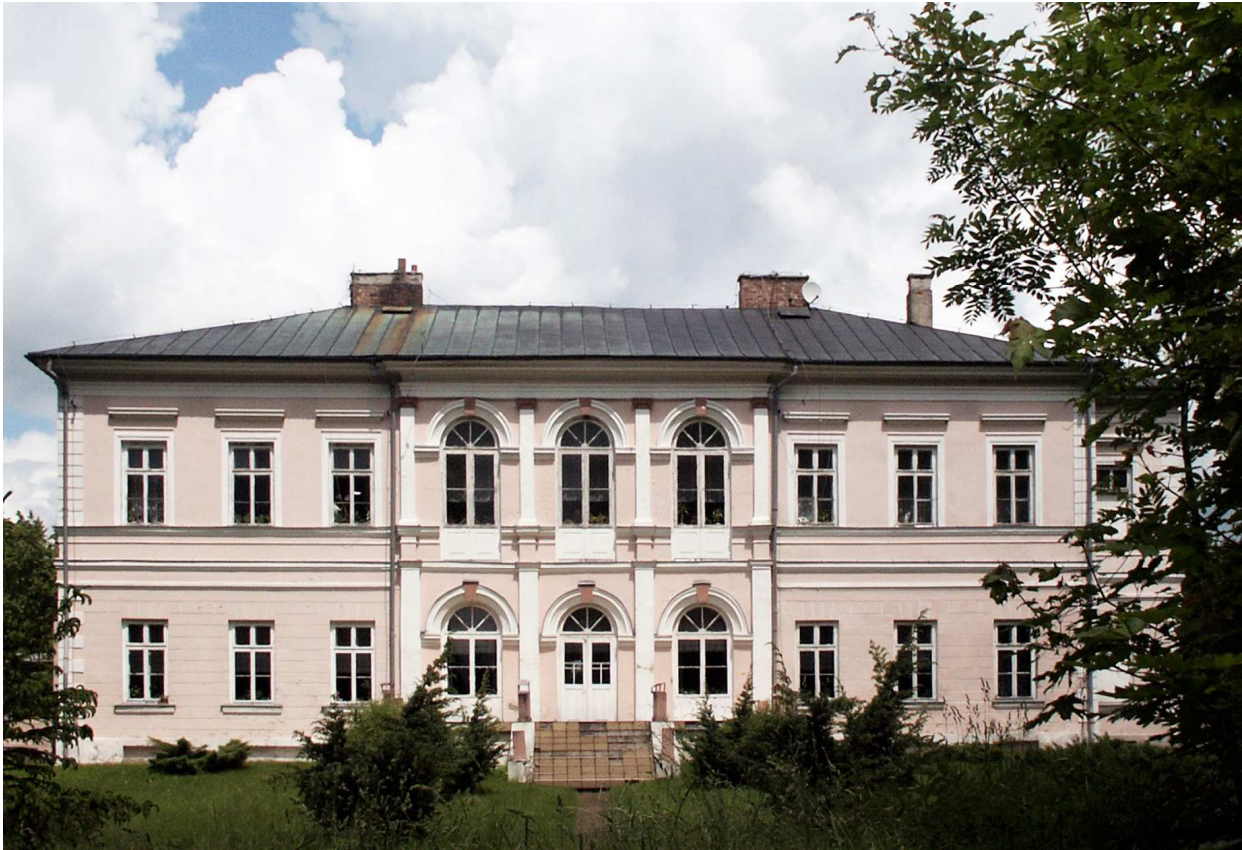
Elewacja ogrodowa, źródło własne
