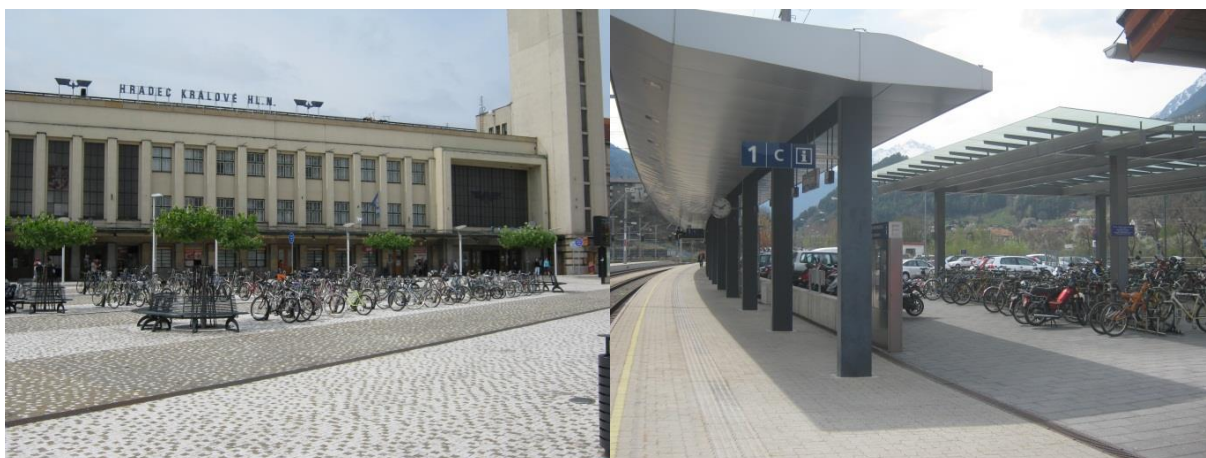
Rys. 12.2 Zdjęcie po lewej przedstawia stojaki rowerowe w systemie B+R przed dworcem kolejowym Hradec Králové hlavní nádraží w Czechach; na zdjęciu po prawej zaprezentowano stojaki rowerowe zamontowane bezpośrednio przy peronie kolejowym na dworcu w Landeck w Austrii. Dodatkowym atutem jest zadaszenie stojaków na całej długości.
