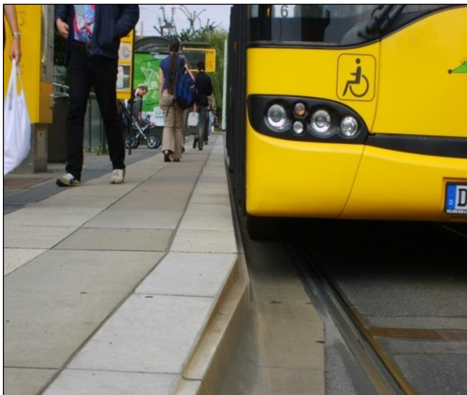
Rys. 8.2 Zalecane ukształtowanie krawędzi peronowej.
