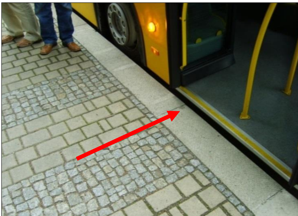
Rys. 8.3 Strefa wejściowa - inny rodzaj nawierzchni naprzeciwko pierwszych drzwi autobusu.
