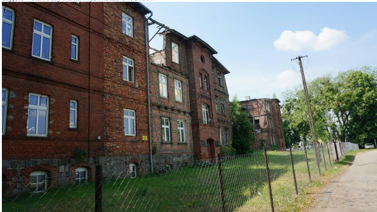
Zdjęcie 4 Stan budynku dawnych koszarów, 2021 r.
