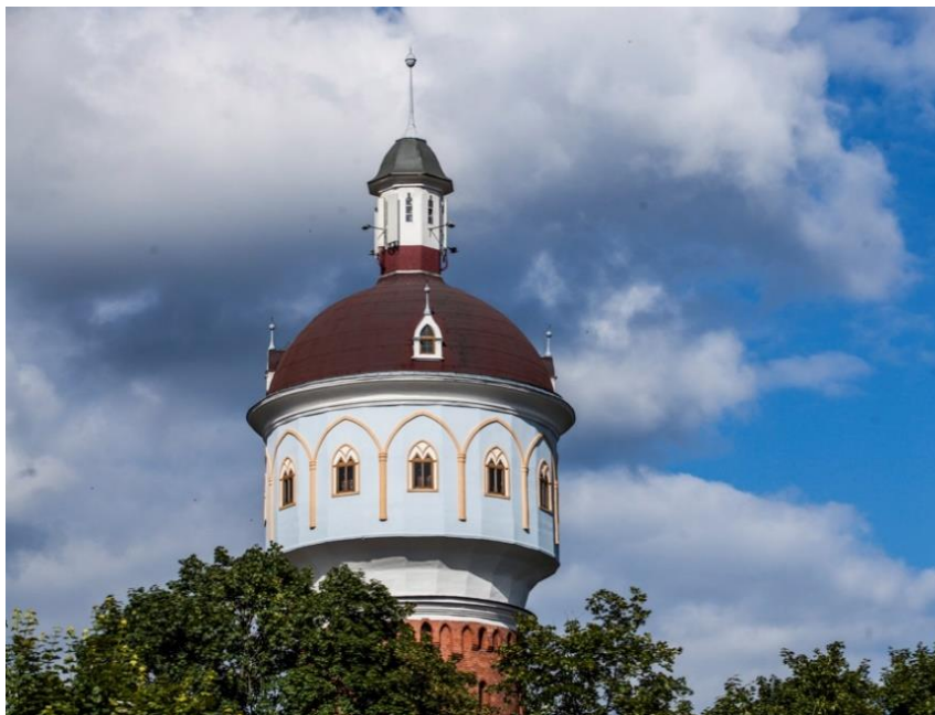
Wieża Ciśnień fot. Urząd Miasta Ełku
