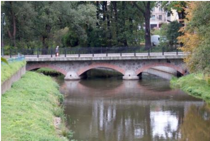
Zdjęcie nr 17. Most drogowy, ciąg ulic Reja-Kopernika
