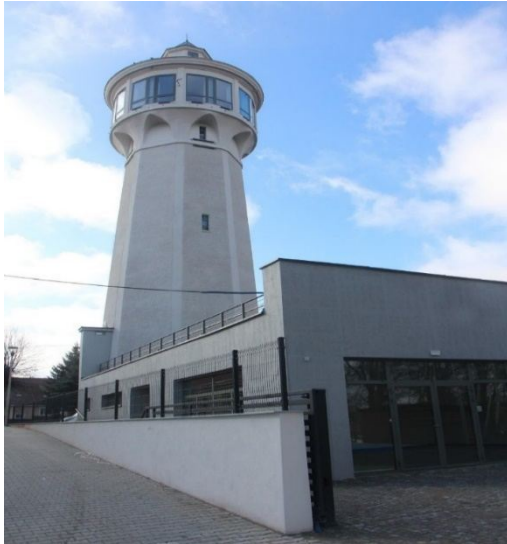
Wodociągowa wieża ciśnień po renowacji w 2020 roku
