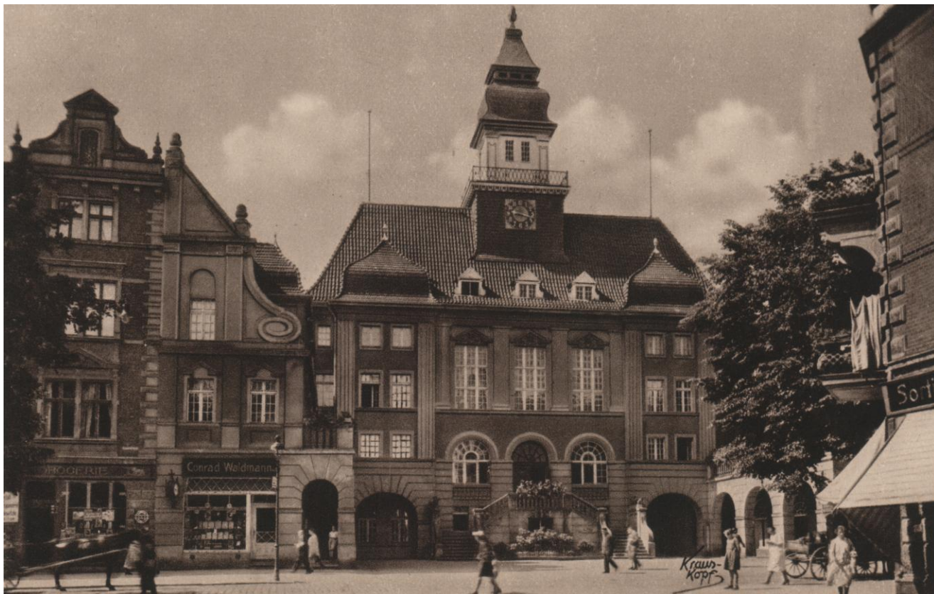
Budynek ratusza, skrzydło zachodnie
