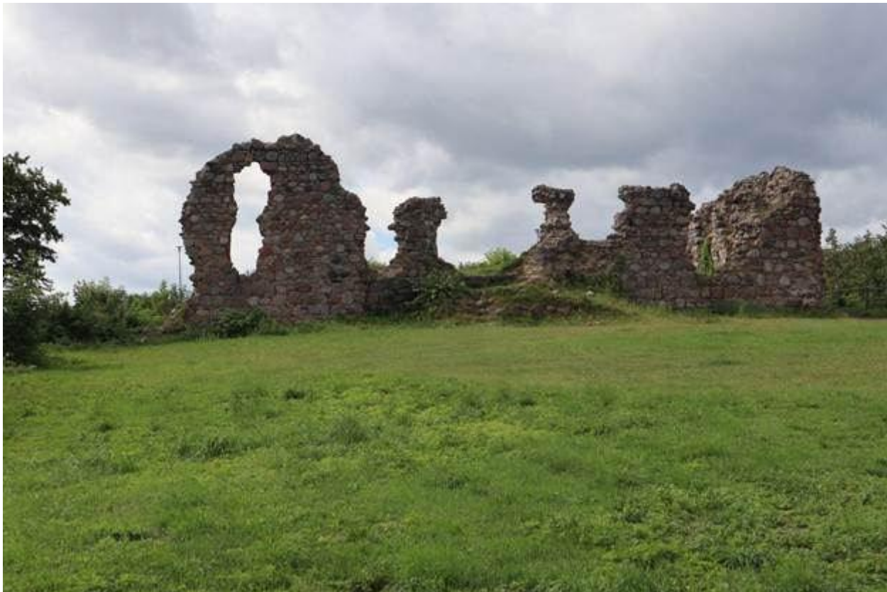
Ruiny zamku kapituły chełmińskiej w Kurzętniku (gm. Kurzętnik)
