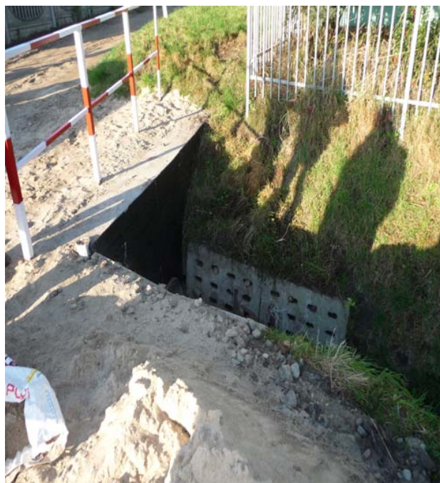
Przepust znajdujący się na działce
