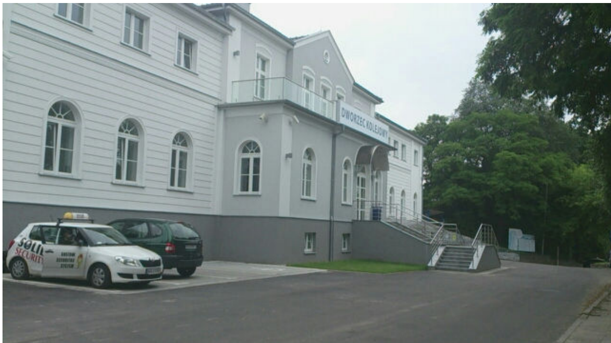
Zdjęcie 2. PKP Dworzec Kolejowy w Gryfinie
