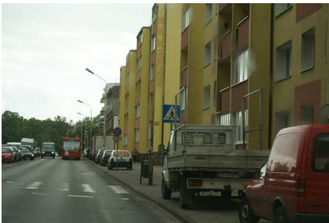
Fot. 6.1-42 Zabudowa 4-kondygnacyjna przy ul. Budziszynskiej w obszarze działania nr D63
