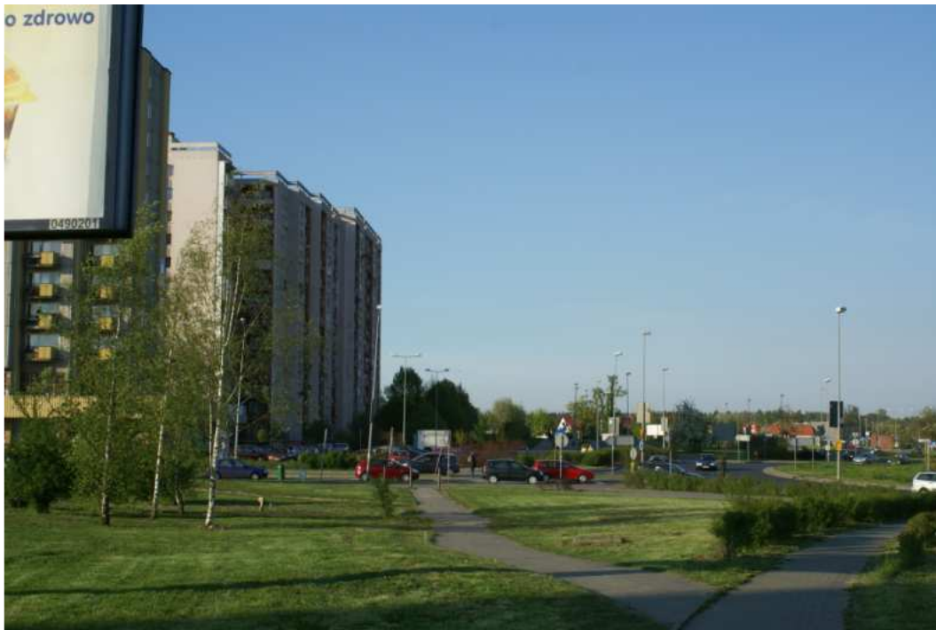
Fot. 6.1-43 Wielokondygnacyjny budynek mieszkalny przy ul. Mieszka I znajduje się w dostatecznie dużej odległości od jezdni, aby uciążliwość akustyczną ograniczyć realizując ekran akustyczny oraz pas zwartej zieleni wysokiej.
