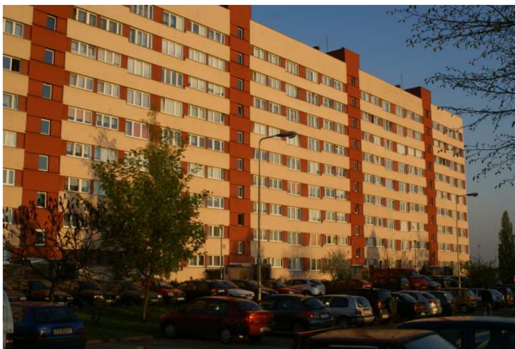
Fot. 6.1-51 Budynki mieszkaniowe ustawione równoległe do uciążliwych ulic są szczególnie narażone na hałas komunikacyjny – obszar działań D-73
