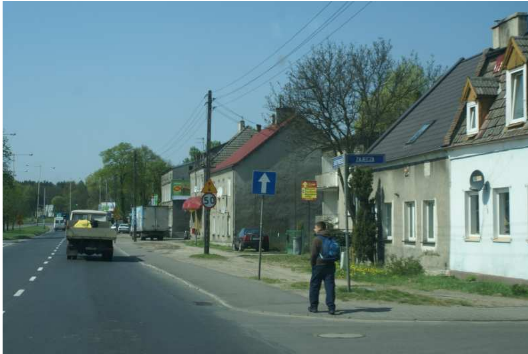
Fot. 6.1-8 W obszarze D4 proponuje się realizację ekranu akustycznego po północnej stronie jezdni. Znaczna odległość pomiędzy zabudową a jezdnią, oraz częste postoje pojazdów czynią to rozwiązanie najbardziej racjonalnym w tym miejscu.
