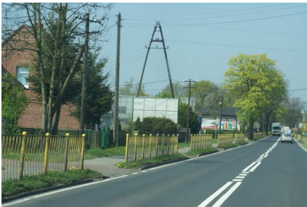
Fot. 6.1-3 Na przeważającej długości odcinka drogi w obszarze działania D1 znajduje się duża liczba włączeń do drogi głównej. Uniemożliwia to zaprojektowane skutecznego ekranu akustycznego.
