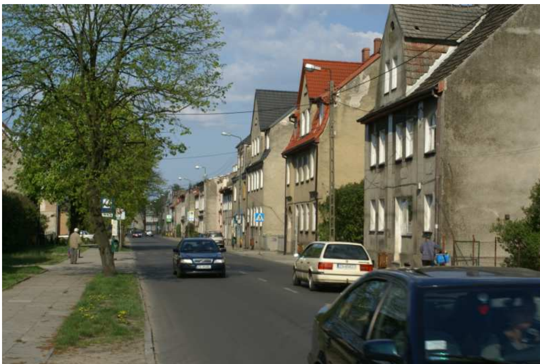
Fot. 6.1-20 Zabudowa mieszkaniowa po południowej stronie ul. Gryfińskiej znajduje się w odległości około 2 metrów od jezdni. Po stronie północnej odległość ta jest około dwukrotnie większa.
