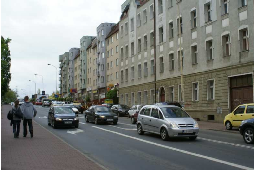
Fot. 6.1-39 Budynki mieszkalne przy ul. Milczańskiej graniczą bezpośrednio z pasem drogowym, przez co ochrona przed hałasem może polegać wyłącznie na poprawie stanu technicznego jezdni.
