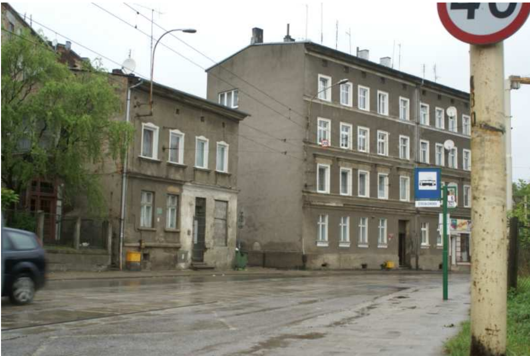
Fot. 6.1-32 W obszarze D31 zabudowa mieszkaniowa wielorodzinna znajduje się w bezpośrednim sąsiedztwie pasa drogowego. Rejon skrzyżowania z ul. Strzałkowską
