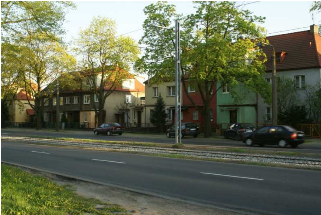
Fot. 6.1-47 Po południowej stronie ul. Ku Słońcu posesje mieszkalne znajdują się w niewielkiej odległości od jezdni – podobnie jak same budynki, co dyskwalifikuje ekran akustyczny jako rozwiązanie problemu nadmiernego hałasu.
