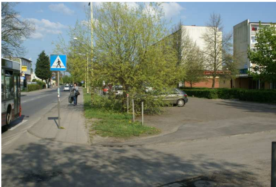
Fot. 6.1-14 Bardzo dobre możliwości zastosowania ekranu akustycznego istnieją także w przypadku budynków przy ul. Batalionów Chłopskich nr 44-60
