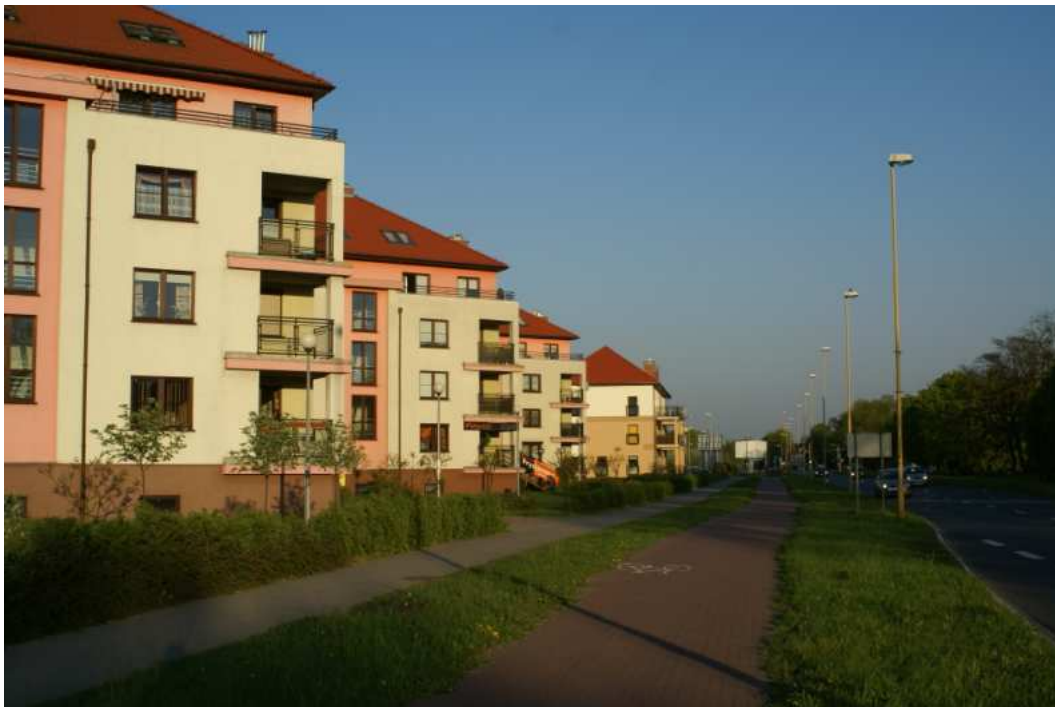
Fot. 6.1-48 W obszarze działania D69 pomiędzy zabudową mieszkaniową 4-kondygnacyjną znajduje się szeroki pas terenu pozwalający na realizację ekranu akustycznego.
