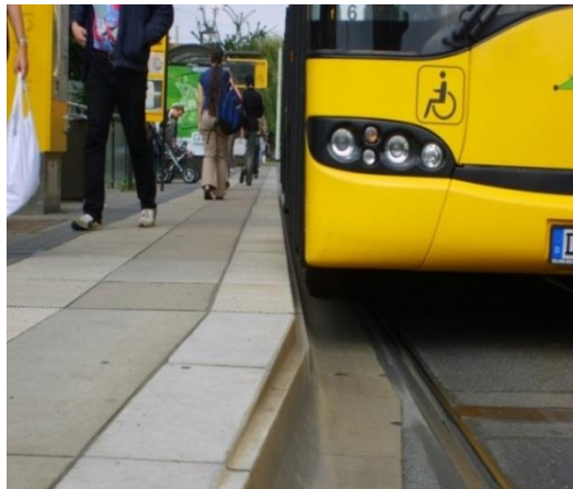
Rys. 9.7.1. Zalecane ukształtowanie krawędzi peronowej.
