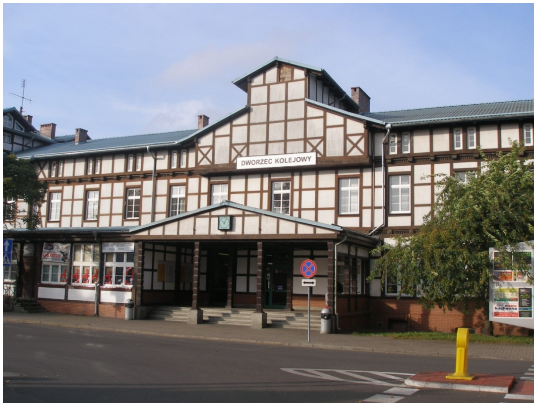
Rys. 10. Budynek dworca PKP w Białogardzie
