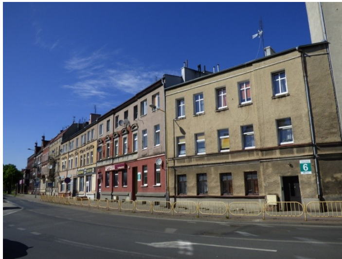
Fot. 24. Pierzeja w ciągu ul. Bogusława w Pyrzycach – przykład budownictwa wielorodzinnego
