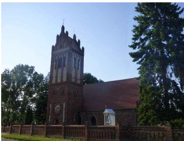
Fot. 37. Kościół w Mechowie Źródło: fotografia własna
