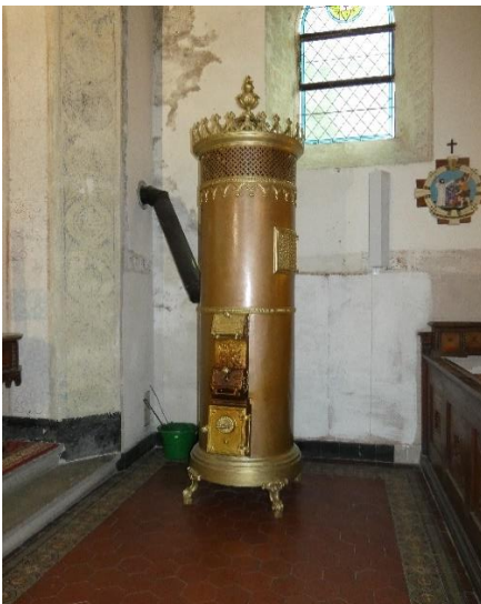
Piec żeliwny w kościele filialnym pw. Św. Jana Chrzciciela w Chmielnie wyprodukowany w końcu XIX w. w założonej w 1887 roku przez inż. H. Kori w Berlinie firmie, która zastąpiła z produkcji pieców do spalania odpadów i kalorycznych podgrzewaczy powietrza, używanych zwłaszcza w budynkach kościelnych.
