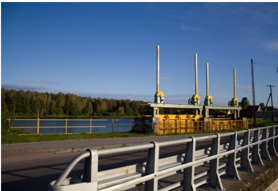
Zespół hydrotechniczny Elektrowni Rosnowo powstały w latach 1910-1924. Zapora o wysokości 10 m z przepustem Starej Radwi i kanał o głębokości 3 m doprowadzający wody do elektrowni w Lisowie.
