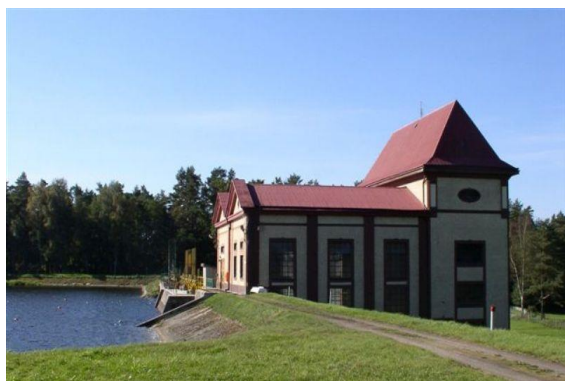
Młyn i elektrownia wodna w Niedalinie.
