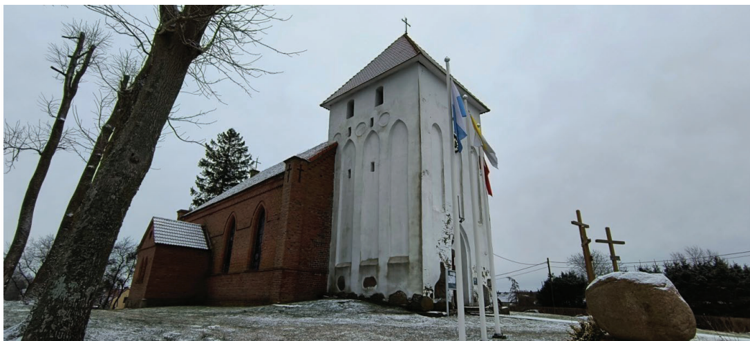
Ryc. 48. Wieża Kościoła Matki Bożej Różańcowej w Marszewie; fot. Edyta A. Marek
