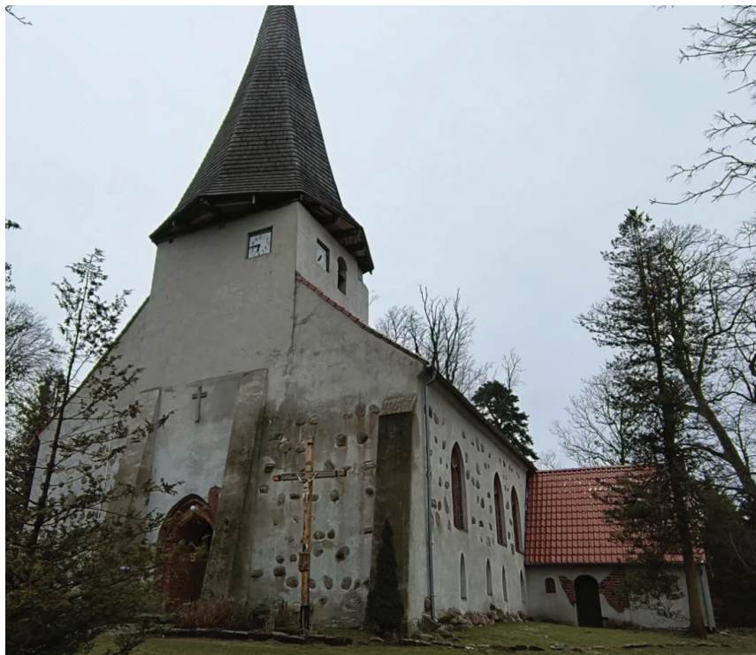
Ryc. 47. Kościół pw. Zwiastowania Najświętszej Maryi Panny w Łącku ; fot. E. A. Marek
