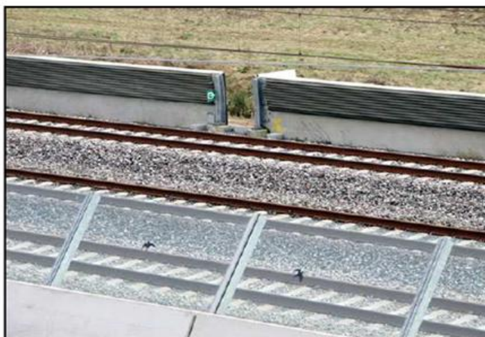
Rysunek nr 16. Widok niskiego ekranu akustycznego przy torowisku kolejowym (Holandia)
