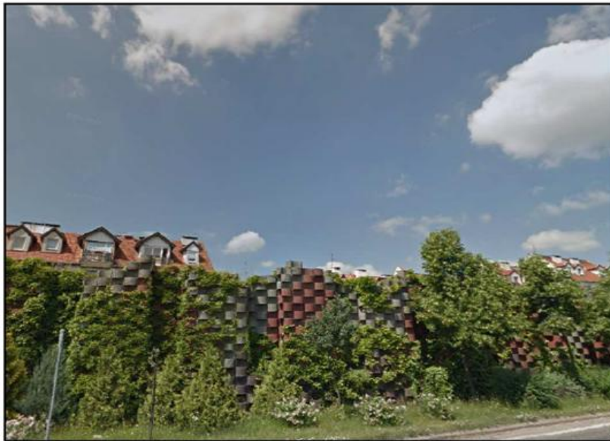
Rysunek nr 10. Widok ekranu akustycznego chroniącego zabudowę mieszkaniową osiedla Ogrody w Lesznie
