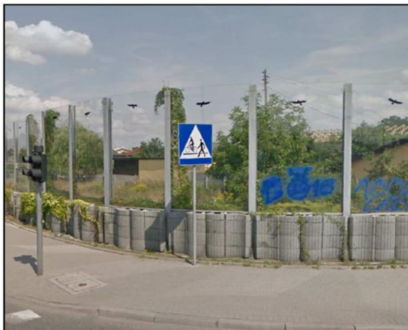
Rysunek nr 13. Widok ekranu akustycznego w rejonie skrzyżowania Trasy Bursztynowej z ul. Zagórowską w Koninie
