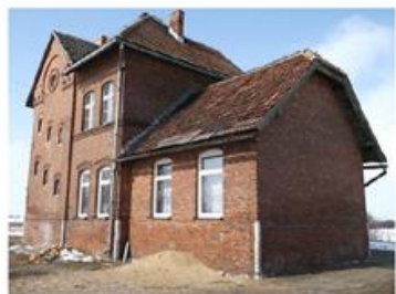
2) Budynek byłej stacji PKP- świetlica wiejska
