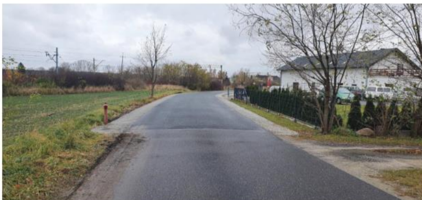
Droga do przejazdu kolejowego w Radlinie
