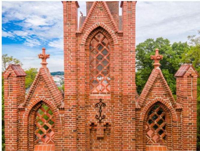
Odbudowana attyka kościoła ewangelickiego w Miłosławiu
