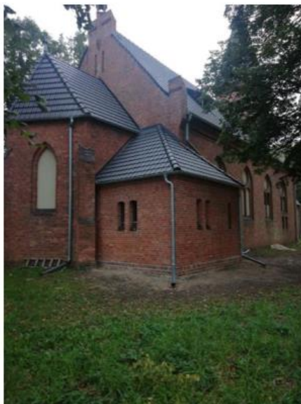
Ryc. 1 Odbudowana zakrystia kościoła poewangelickiego w Ryczywole
