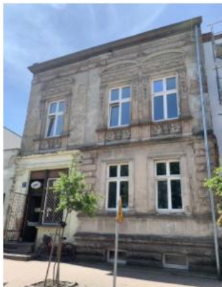
Fot. 76. Dom, Plac Powstańców Wielkopolskich 7 w Rogoźnie, nr rejestru A-543 z 29.12.1986 r. (fot: A. Bąk, A. Nagóma, 2023)
