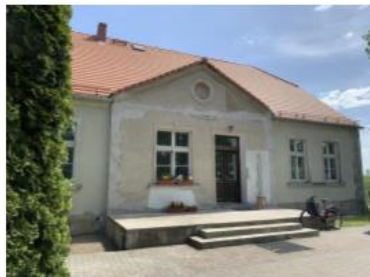
Fot. 98. Plebania w Pruszcach, nr rejestru A-215/1100 z 29.04.1970 r. (fot: A. Bąk, A. Nagórna, 2023)
