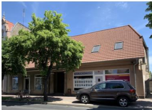
Fot. 79. Dom, ul. Wielkopoznańska 29 w Rogoźnie, nr rejestru A-874 z 7.10.1970 r. (fot: A. Bąk, A. Nagóma, 2023)
