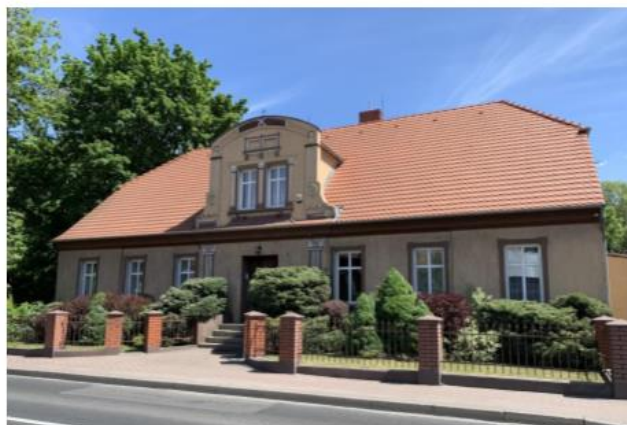
Fot. 66. Plebania, ul. Kościelna 10 w Rogoźnie, nr rejestru A-544 z 29.12.1986 r. (fot: A. Bąk, A. Nagórna, 2023)
