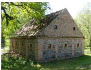
Fot. 90. Stajnia w Jaracz Młyn, nr rejestru A-752 z 30.12.1993 r. (fot: A. Bąk, A. Nagórna, 2023)
