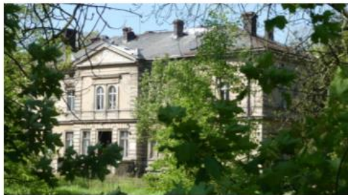
Fot. 33. Pałac w Łukowie, nr rejestru 306/A z 17.10.1968 r. (fot: A. Bąk, A. Nagóma, 2023)
