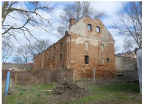
Fot. 7. Skrzydło dawnego klasztoru franciszkanów, obecnie magazyn, ul. Sądowa w Obornikach, nr rejestru 1169/A z 17.07.1970 r. (fot: A. Bąk, A. Nagórna, 2023)
