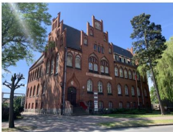
Fot. 72. Sąd, obecnie szkoła, ul. Kościuszki 41 w Rogoźnie, nr rejestru 254/Wlkp/A z 17.10.2005 r. (fot: A. Bąk, A. Nagórna, 2023)
