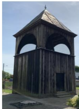
Fot. 95. Dzwonnica w Parkowie, nr rejestru 1587 z 29.07.1974 r. (fot: A. Bąk, A. Nagórna, 2023)
