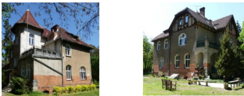
Fot. 23-24. Willa lekarza w Kowanówku, nr rejestru 2297/A z 24.02.1994 r. (fot: A. Bąk, A. Nagórna, 2023)
