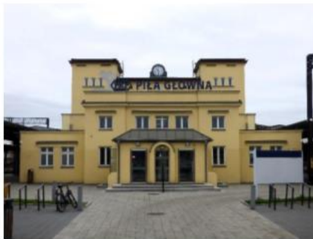
Fot. 18. Dworzec kolejowy w Pile
