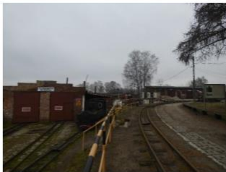
Fot. 10. Kompleks budynków stacji wąskotorowej w Białośliwiu
