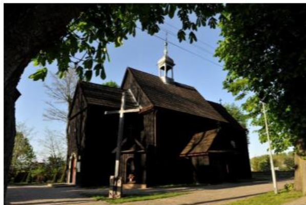
Fot. 2. Kościół w Kleszczewie z 1760-62r.
