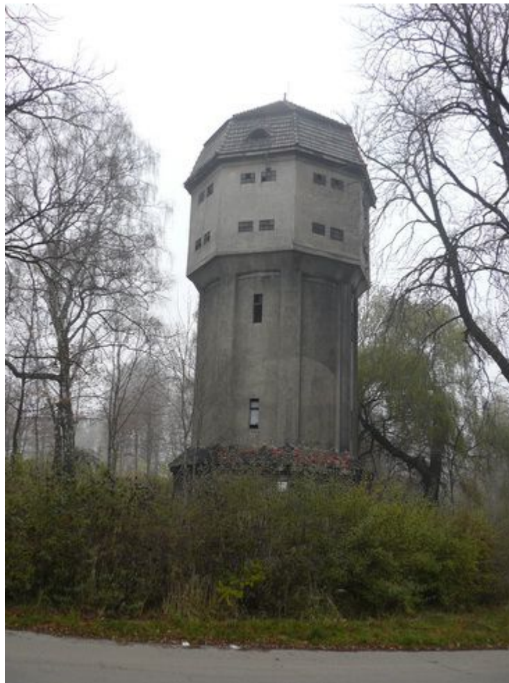
Ilustracja 59: Wieża wodna w zespole dworcowym.
