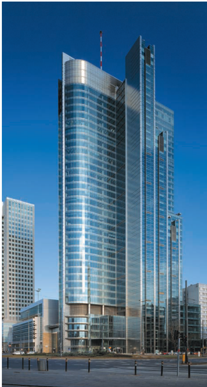
Budynek: Rondo 1 Miasto: Warszawa Deweloper: Hochtief Development Poland
