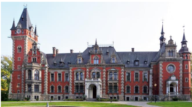
Palac w Plawniowicach [źr.:strona pałacu w Plawniowicach]
