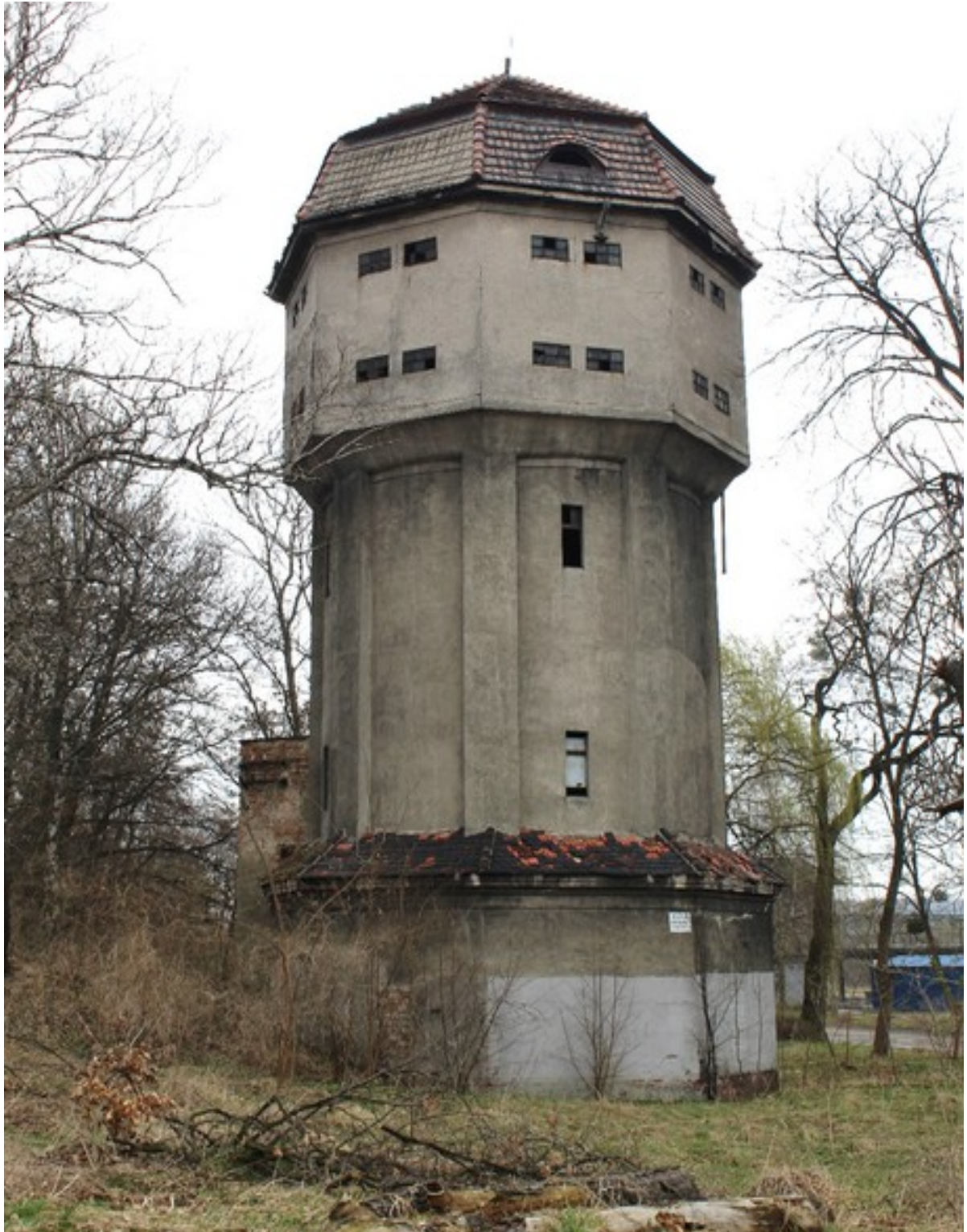
Ilustracja 62. Wieża Ciśnień – ul. Dworcowa 3. Lata 1900 – 1910.
