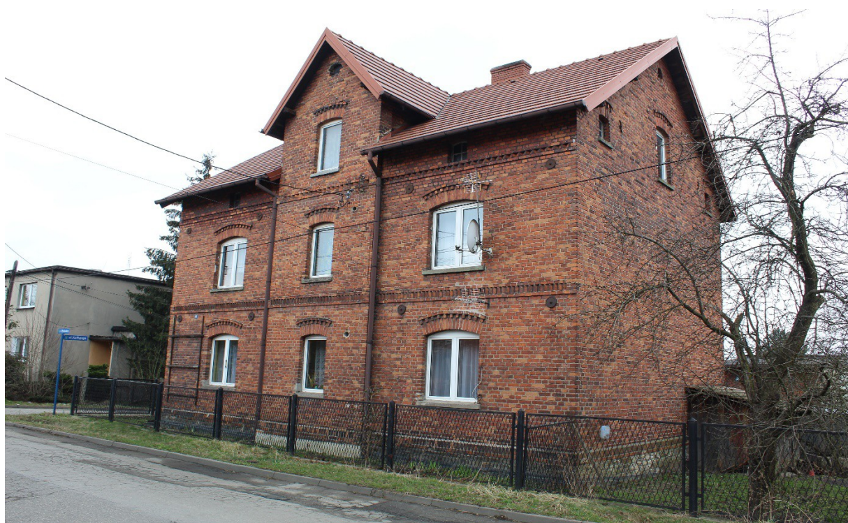
Ilustracja 52. Orzesz, ul. Rybnicka 119. Budynek mieszkalny z 1926 r.
