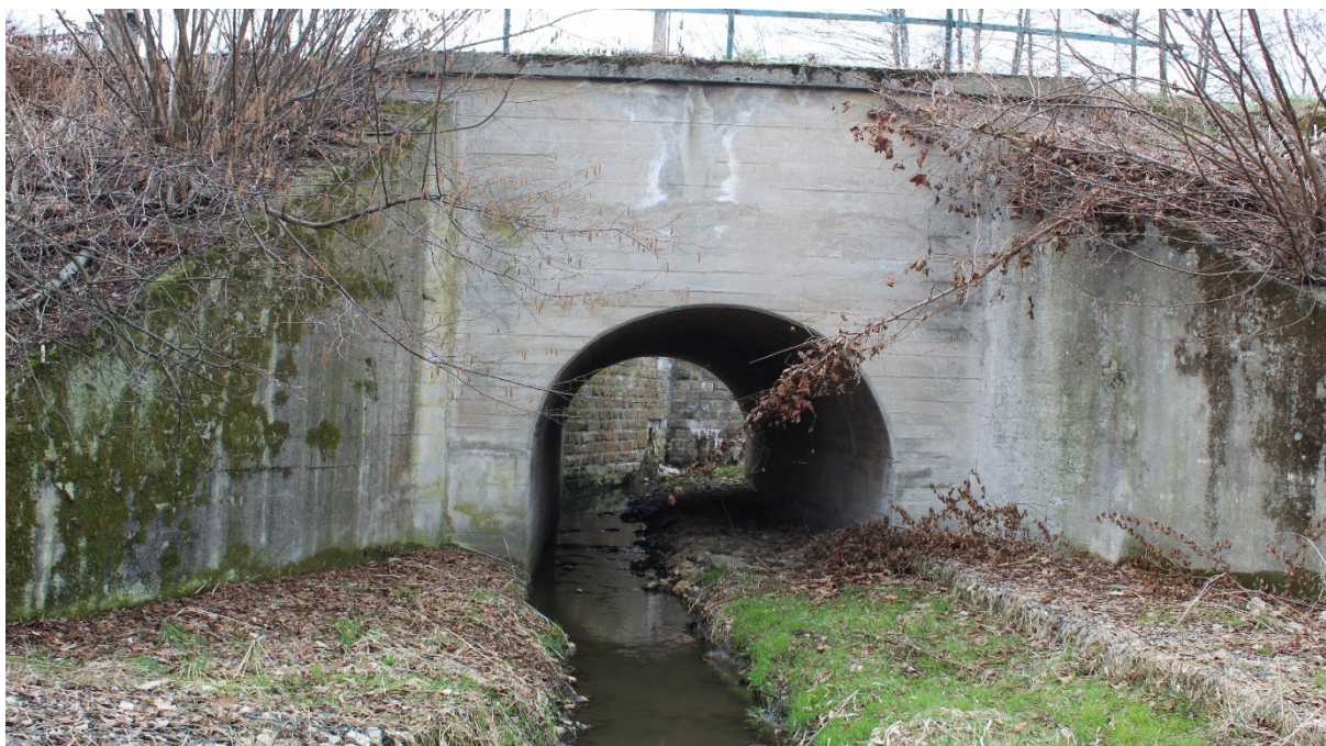
Ilustracja 63. Orzesze, ul. Bukowina 75, przepust wodny na Bierawce, sklepiony, ceglano – betonowy, z pocz. XX w.
