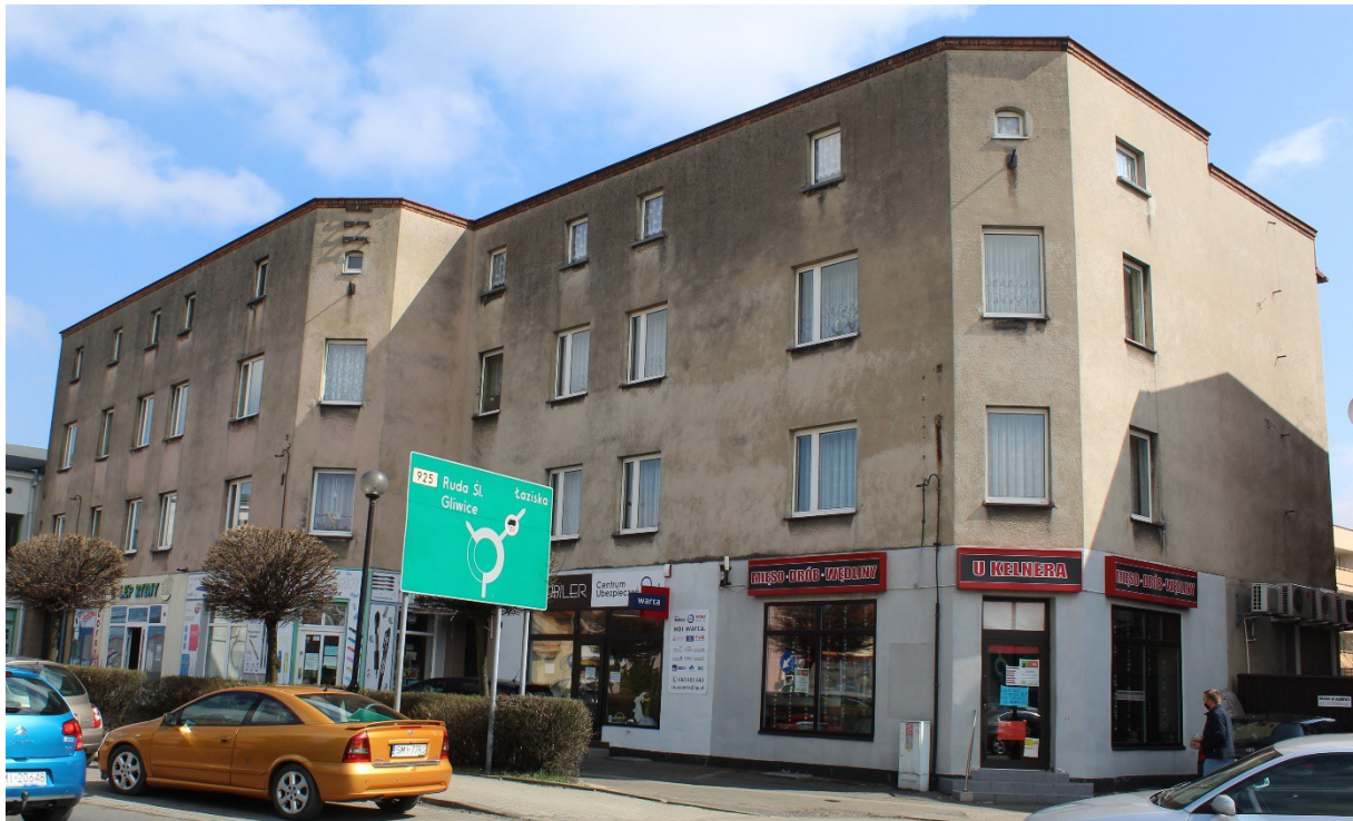
Ilustracja 48A. Orzesze, ul. Rynek 2-3. Budynek mieszkalno – usługowy w typie kamienicy miejskiej.
