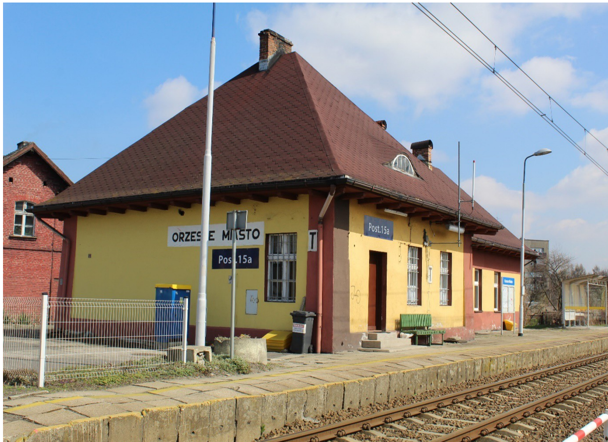
Ilustracja 59. Budynek dworca kolejowego Orzesze Miasto ul. Rybnicka 15. Lata 1910 – 1920.
