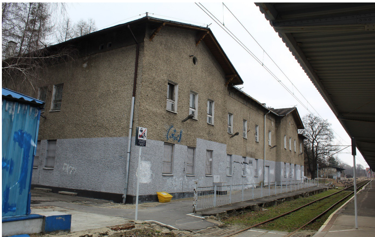
Ilustracja 58. Zespół zabudowy stacji kolejowej Orzesze, ul. Dworcowa 3 – budynek dworca kolejowego. Lata 1900 – 1910.
