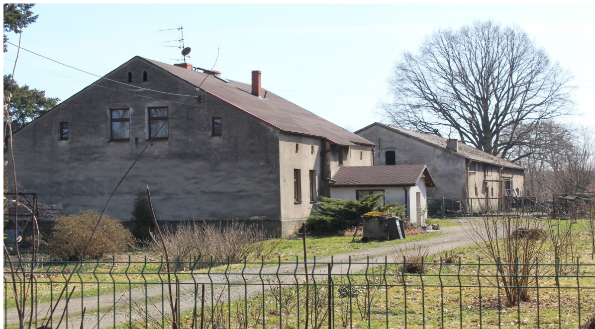
Ilustracja 76. Zawada ul. Dębową 5-7. Zespół zabudowy dawnego folwarku. Początek XX w.
