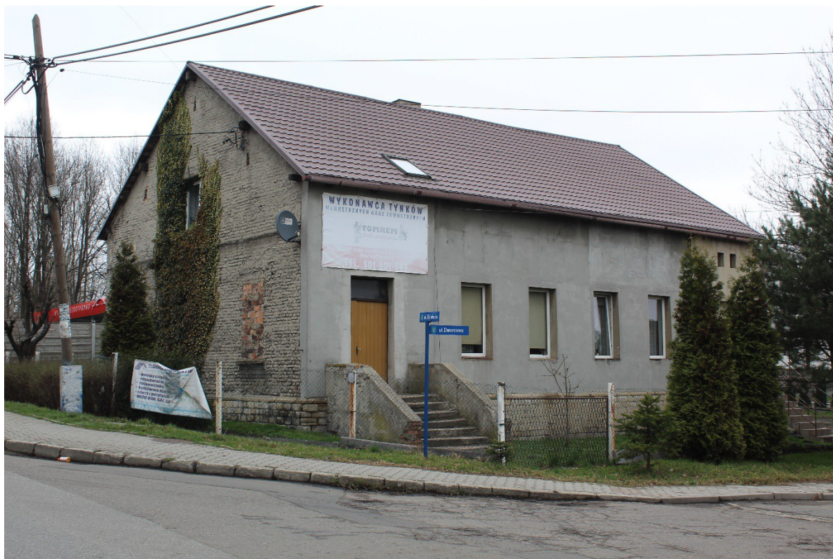
Ilustracja 60. Zespół zabudowy dawnej Zjednoczonej Kopalni Fryderyk i Orzesze, ul. Dworcowa 1– dawny budynek administracji. Koniec XIX w.
