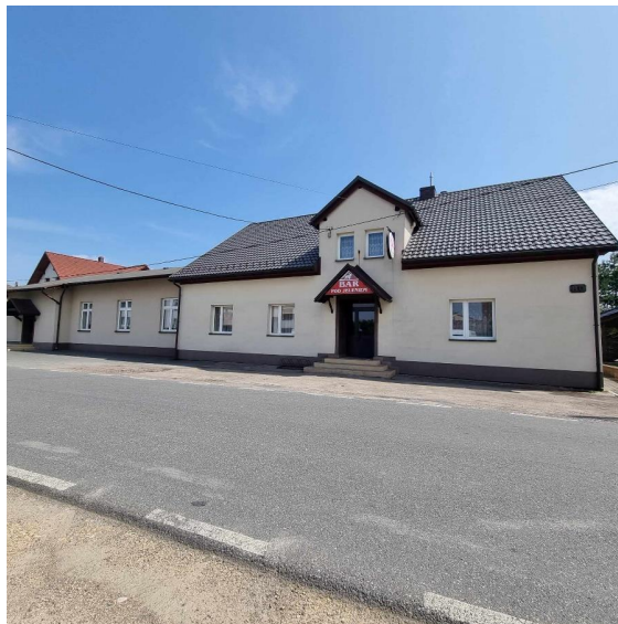
Fotografia 2. Miedźna, budynek dawnej gospody przy ul. Wiejskiej 80.
