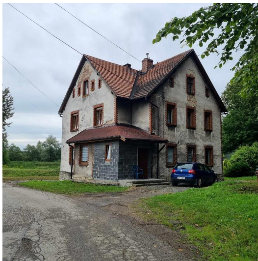
Fotografia 3. Dawny budynek urzędu celnego w Górze przy ulicy Nad Wisłą 23.
