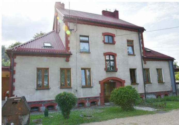
Fotografia 4. Góra ul. Pszczyńska 11, dawny dom mieszkalny niemieckich strażników granicznych.
