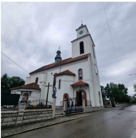
Fotografia 14. Wola, ul. Szkolna 44, kościół murowany z XIX w.
