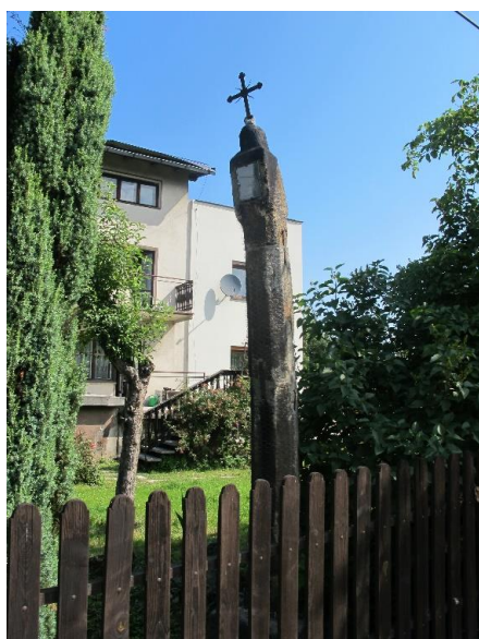
Zagrożona kapliczka kamienna Kobiernice ul. Centralna 4
