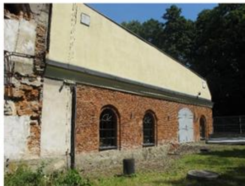
Czaniec, budynek siłowni z turbinami Girarda
