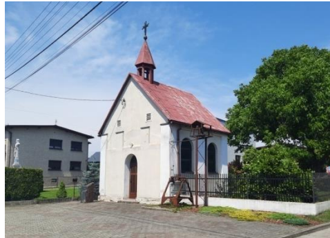
Fot. 79 Kaplica Szczekowicach ul. Rybnicka
