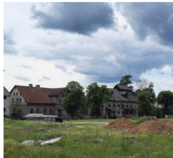
Fot.6 Zabudowa folwarczna przy ulicy Majątkowej w Bełku
