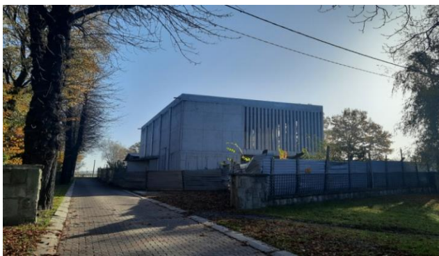
Fot. 70 Widok w kierunku zachodu – budowa
