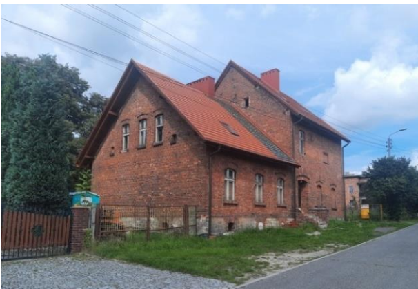
Fot. 80 Dawna szkoła w Palowicach ul. Szkolna
