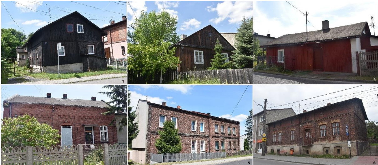
Fot. 6. 1) Bobrowniki, ul. 1 Maja 87; 2) Bobrowniki, ul. 1 Majam59; 3) Rogóżnik, ul. Okrzei 26; 4) Bobrowniki, ul. Sienkiewicza 189; 5) Bobrowniki, ul. Sienkiewicza 304-306; 6) Dobieszowice, ul. Kościuszki 53 (fot. autor opracowania).
