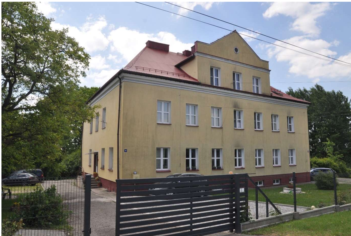
Ilustracja 55 SKRBEŃSKO UL. PIOTROWICKA 108. DAWNY BUDYNEK STRAŻY GRANICZNEJ, OBECNIE BUDYNEK WIELORODZINNY. ZASOBY WŁASNE 2024 R.
