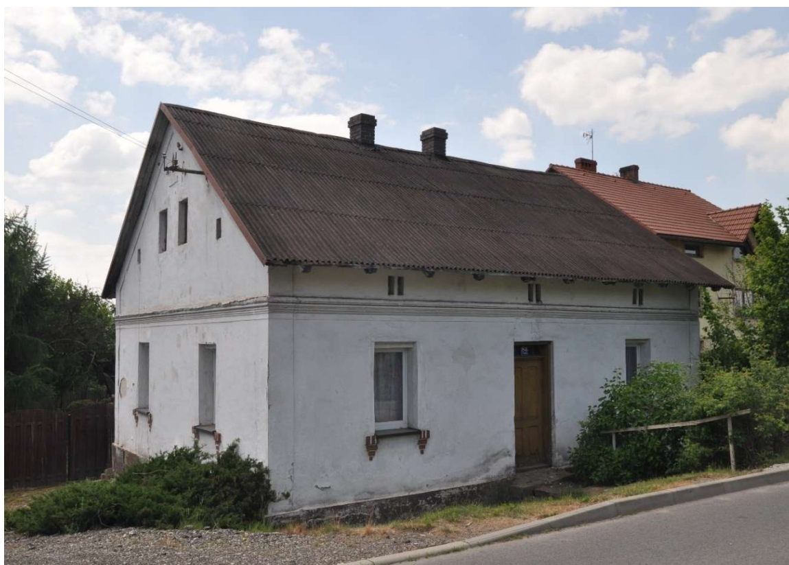
Ilustracja 65 SKRBEŃSKO UL. PIOTROWICKA 84. BUDYNEK JEDNORODZINNY O CHARAKTERZE WIEJSKIM. ZASOBY WŁASNE 2024 R.
