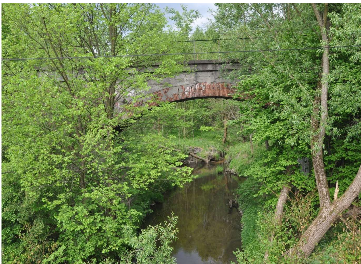
Ilustracja 81 GODÓW UL. POWSTAŃCÓW ŚLĄSKICH, WIADUKT KOLEJOWY. ZASOBY WŁASNE 2024 R.
