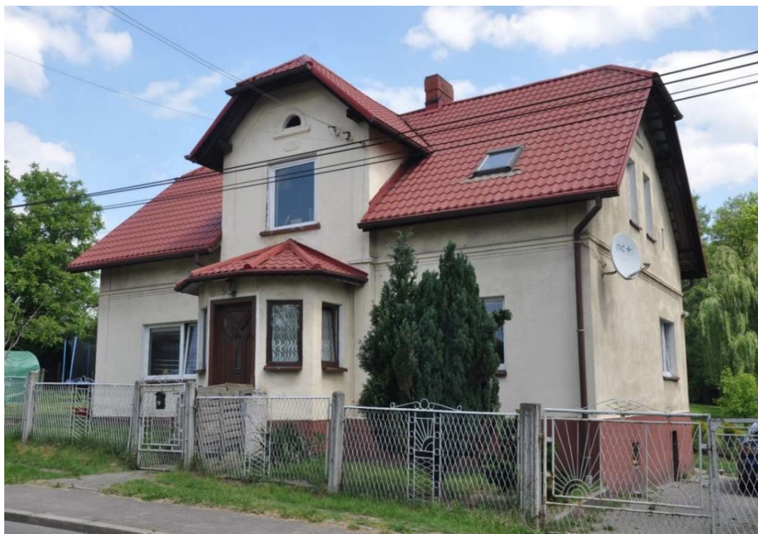
Ilustracja 67 GOŁKOWICE UL. CELNA 9. BUDYNEK JEDNORODZINNY O CHARAKTERZE WIEJSKIM Z FACJATKĄ. ZASOBY WŁASNE 2024 R.
