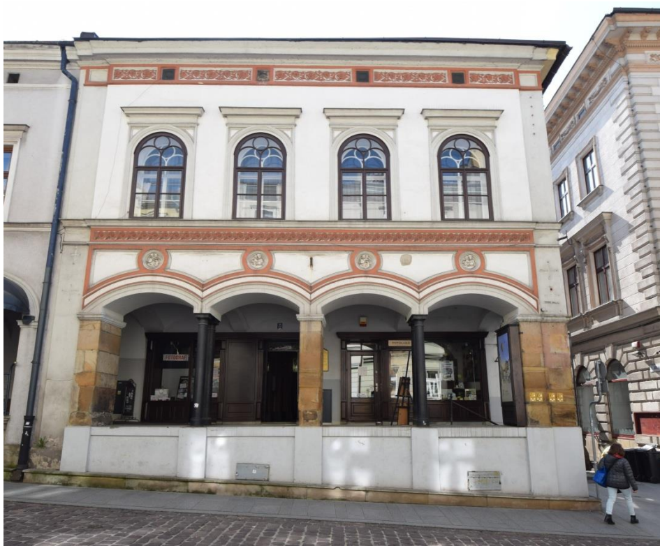
Il. 31. Cieszyn, ul. Głęboka, kamienica pod nr 23, fot. Michał Horbowicz, marzec 2025
