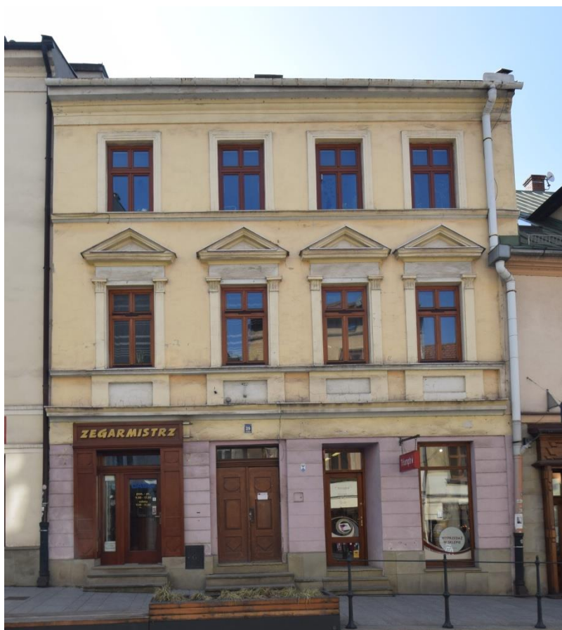
Il. 33. Cieszyn, ul. Głęboka, kamienica pod nr 39, fot. Michał Horbowicz, marzec 2025
