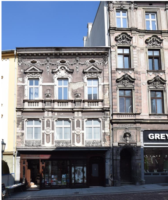
Il. 46. Cieszyn, ul. Głęboka, kamienice pod nr 28 oraz 26 (fragment), fot. Michał Horbowicz, marzec 2025
