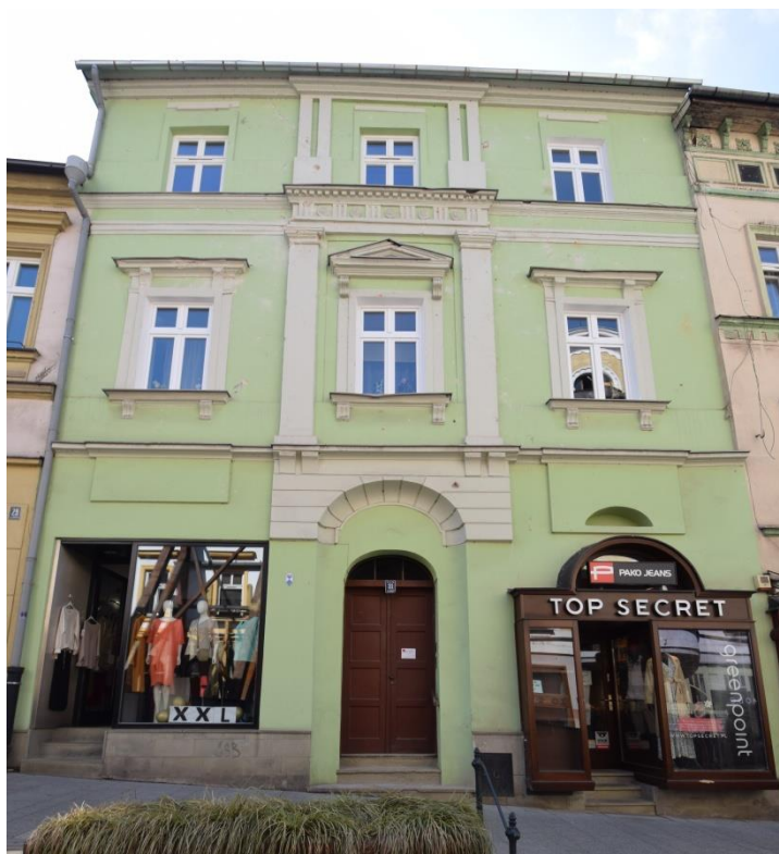
Il. 32. Cieszyn, ul. Głęboka, kamienica pod nr 31, fot. Michał Horbowicz, marzec 2025
