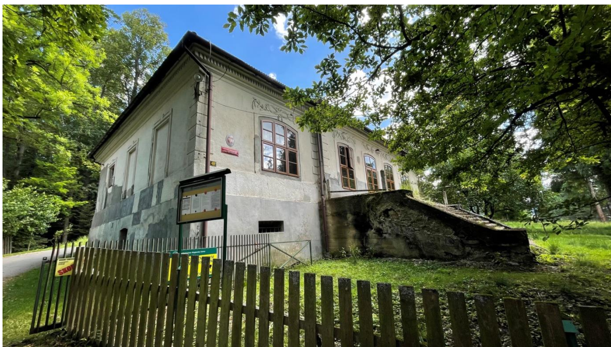
Dwór od strony południowo-zachodniej
