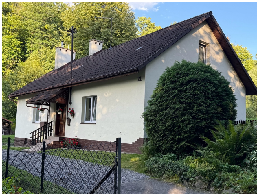
Dom przy ul. Pod Młyńską Kępą 21
