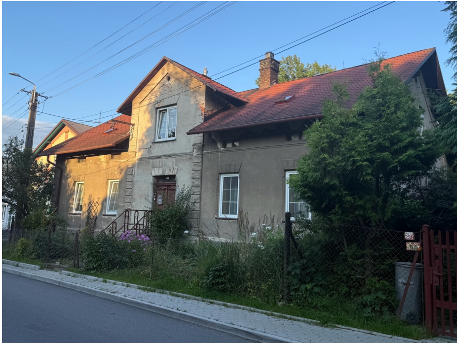
Dom przy ul. Zdrojowej 39
