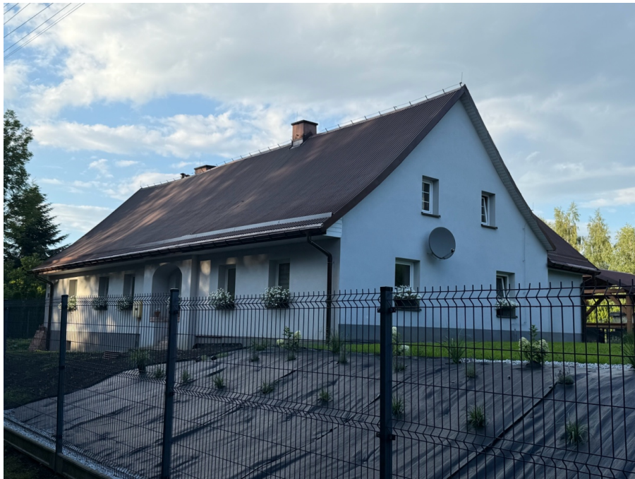
Dom przy ul. Pod Młyńską Kępą 18
