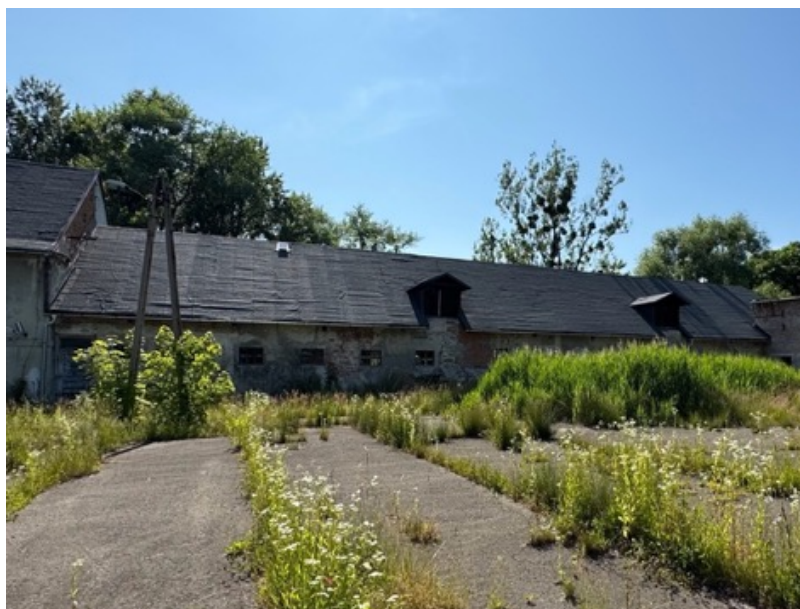
Stajnie w Folwarku dolnym
