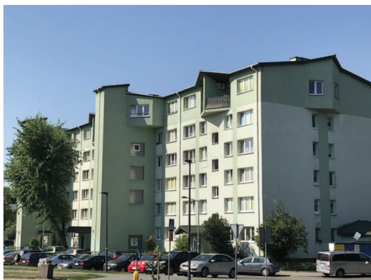
Rys. 18. Przykłady nadbudowy budynków wielkopłytowych i dobudowy zewnętrznych klatek schodowych (z szybami windowymi) /źródło: J. Szulc/
